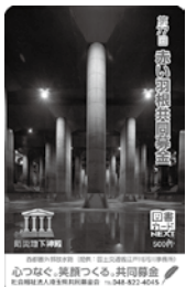
首都圏外郭放水路 (春日部市)
